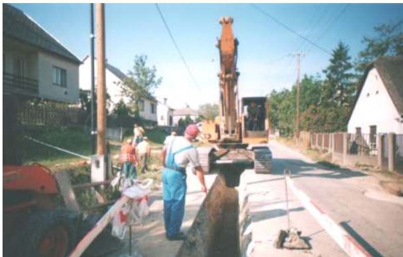
Csatornaépítés a Kossuth utcában
